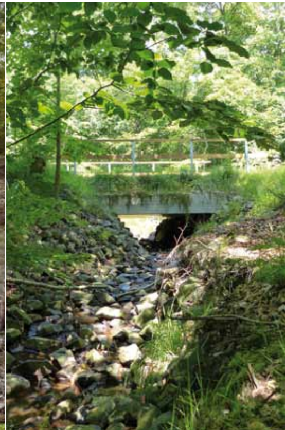
Ersatz eines Rohrdurchlasses durch eine Brücke am Gebrother Bach
