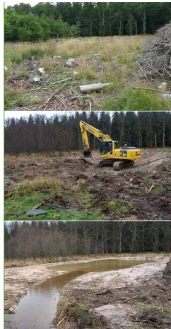
Anlage einer Sickermulde zur Wiedervernässung einer Entfichtungsfläche - biotopgerechte Ausführung als temporäres Stillgewässer
