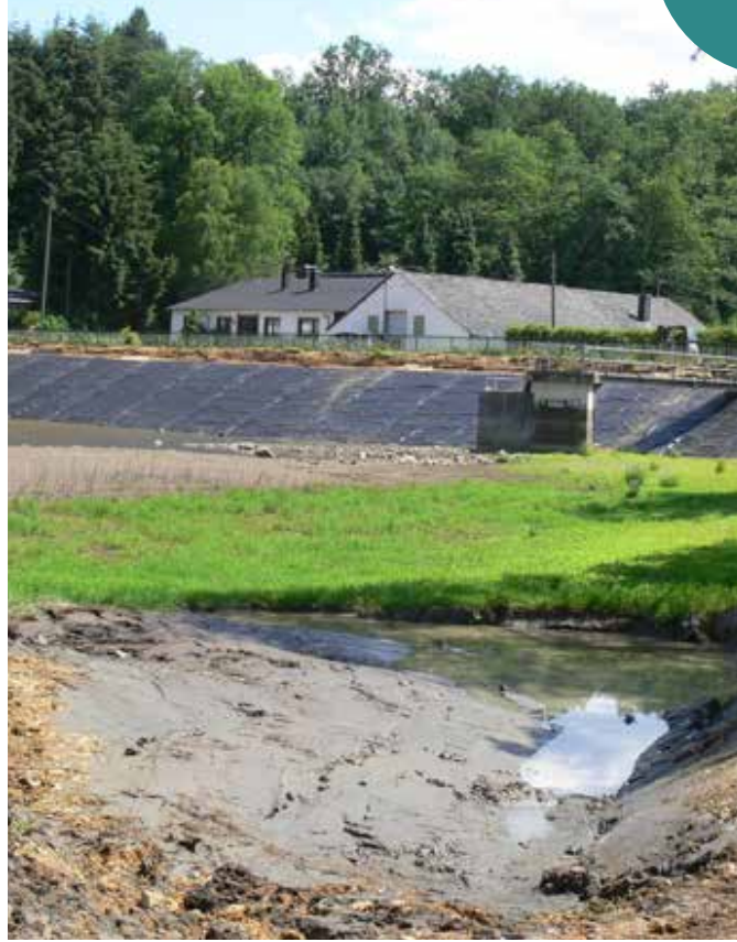
▲ Bauarbeiten am Weiher | © P. Merzhäuser
