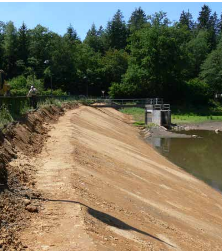
◀ Arbeiten an der Verlandungszone | © P. Merzhäuser
