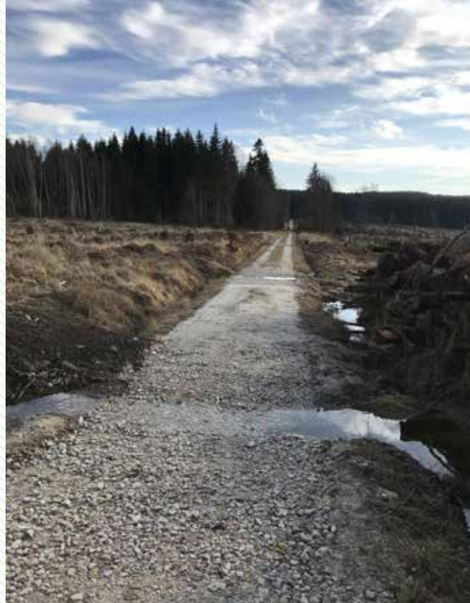
▲ Furten zur Restauration des Wasserhaushalts im Thranenbruch | © SNU
