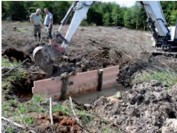
Grabenverschluss im Moor
