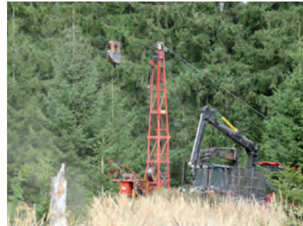
Kraneinsatz auf sensiblen Standorten
