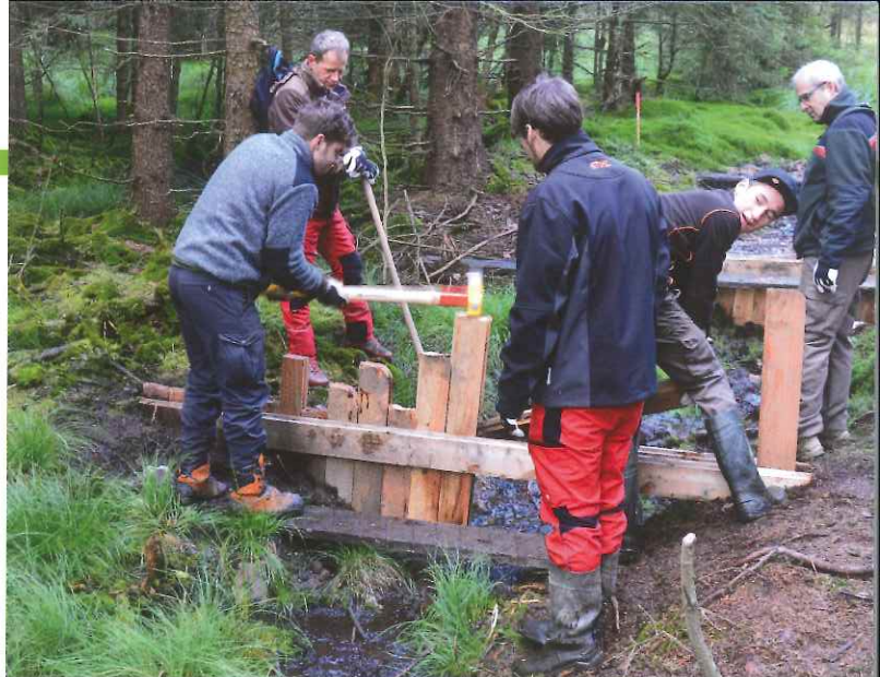
Exkursionsteilnehmer beim Bau am Wasserrückhalt.
