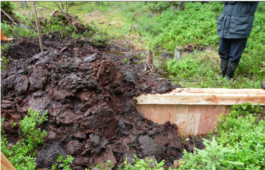
Abb 38: Einbau eines Kleinstaus in einen Entwässerungsgraben mit anschließender Übererdung mit Torf.
