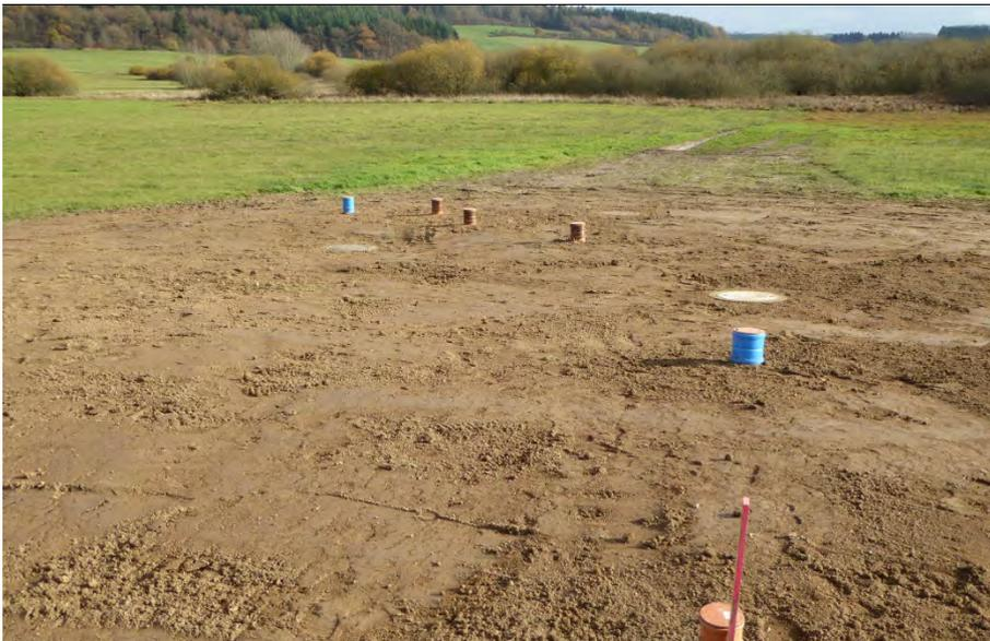
Abb 18: Übererdete Denitrifikationsanlage mit Selbstbegrünung auf dem aufgetragenen Mutterboden.
