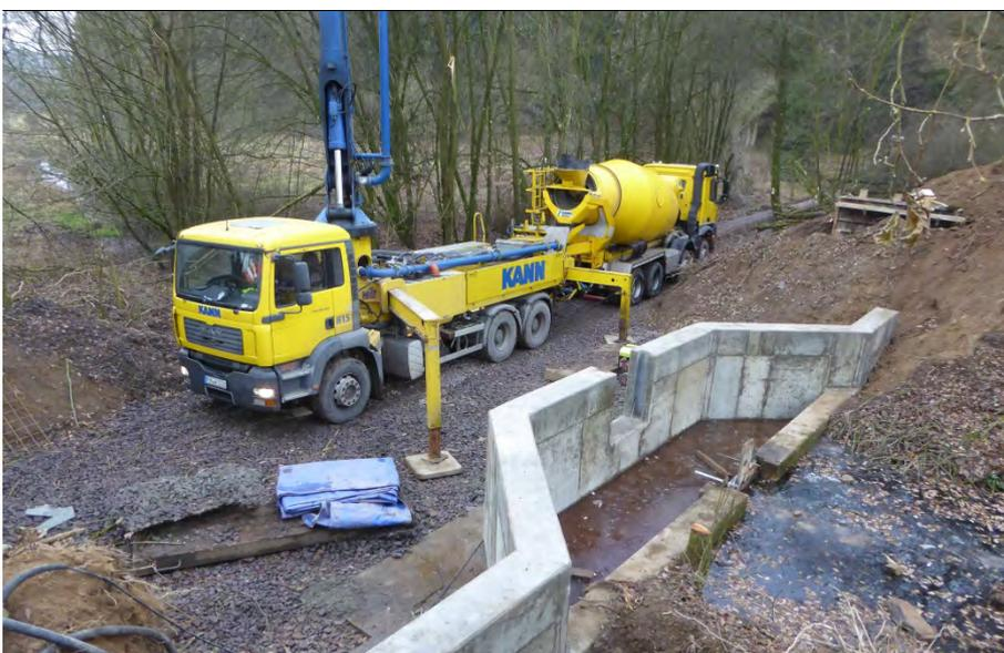
Abb 19: Bau des neuen Stauwehrs am Ablauf.
